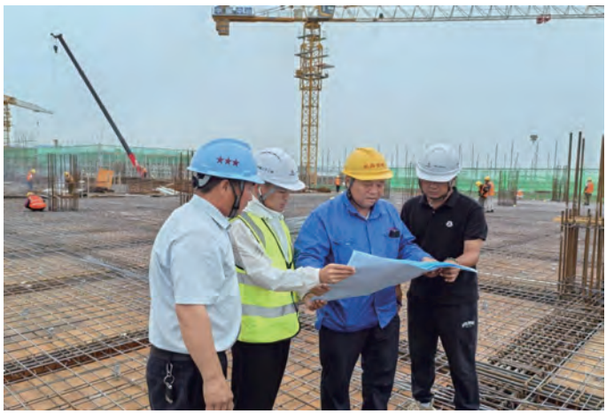
近日,江苏凯实金桥公司年产16.8万吨新能源电池关键材料及关联产品项目呈现一派繁忙景象,施工人员正在紧锣密鼓推进工程进度,重大项目部深入各施工区域开展实地检查,确保新项目高质量推进。(刘佳)
